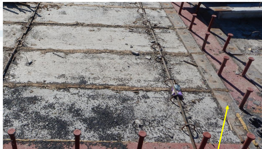
2. Закладные монтажные пластины выполнены из черного железа, лежат на поясах балок
