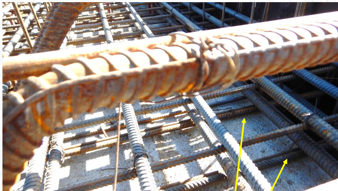
1. Нижние стержни рабочей арматуры плиты лежат на несъемной опалубке
