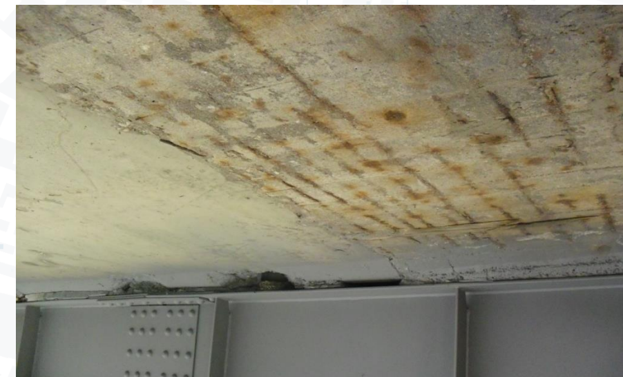
2. «Открытая» плита. Видны дефекты плиты (протечки, коррозия) и упоров
