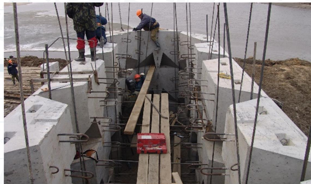
2. Железобетонные контурные блоки опор
