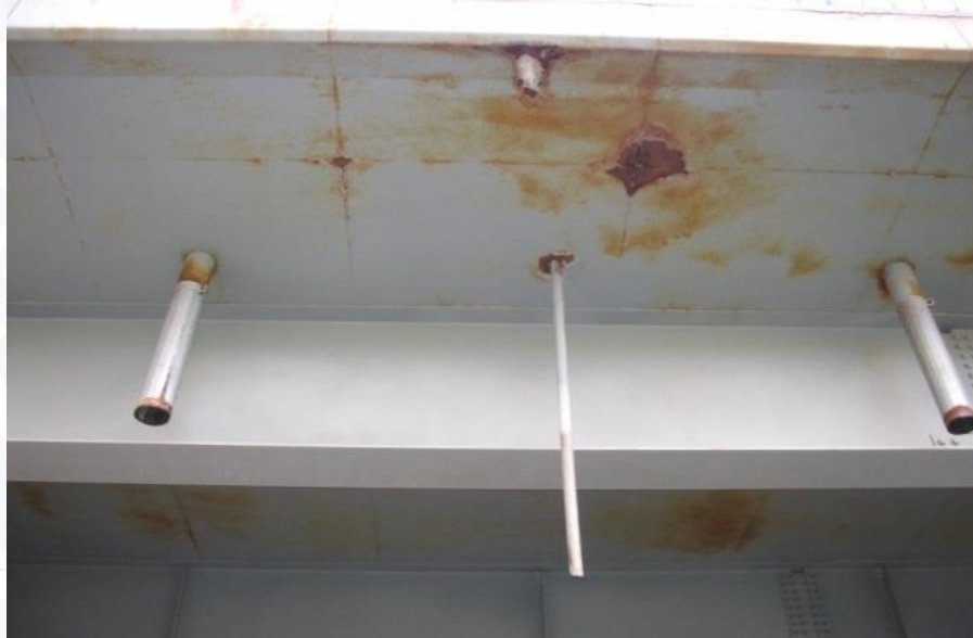
1. Плита в стальной несъемной опалубке. Видны только дефекты опалубки
