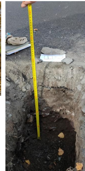
Проходка шурфа
