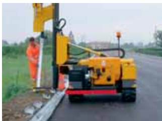
Рис. 3.3. Установка удерживающих ограждений и устройство остановки общественного транспорта
