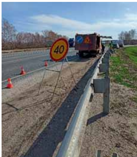
1.2. Процесс вскрытия обочины с размещением в ней колодца ЛКС ТМК на автомобильной дороге М-5 «Урал» (слева) и Р-229 Самара – Пугачев – Энгельс – Волгоград (справа) с сужением проезжей части и ограничением скорости движения автомобилей до 40 км/ч при производстве работ
