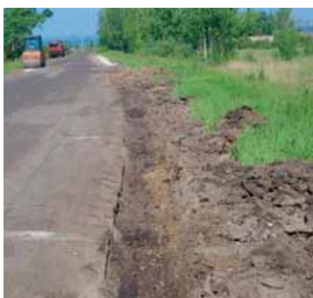
Рис. 3.2. Восстановление кромки проезжей части при ремонте автомобильной дороги
