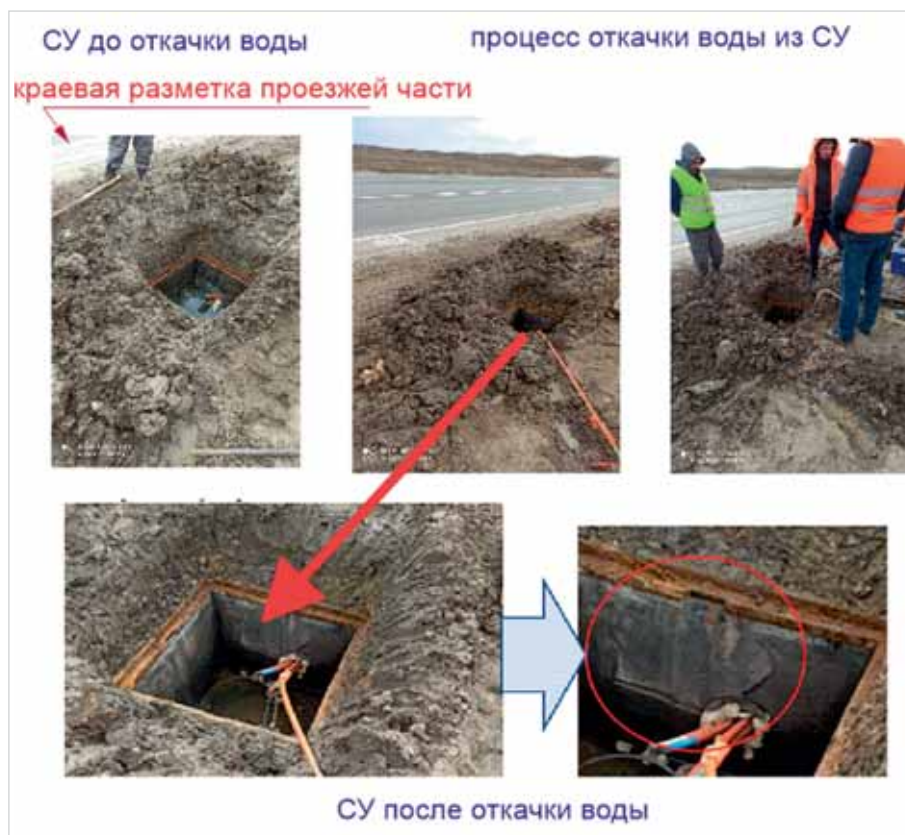
Рис. 5. Затопление и повреждение СУ в обочине автомобильной дороги Р-229 Самара – Пугачев – Энгельс – Волгоград (НК ЛКС ТМК № 13, км 12+694)
