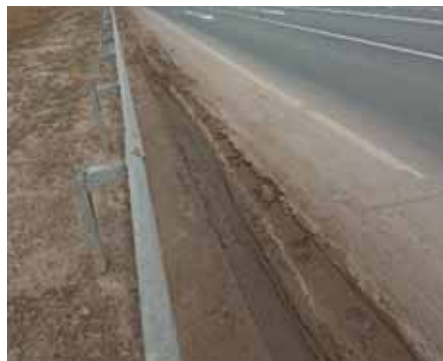
Рис. 2. Продавливание обочин под действием колесной нагрузки
