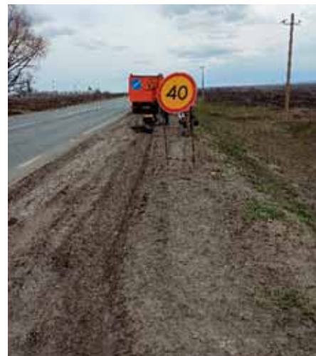
1.2. Процесс вскрытия обочины с размещением в ней колодца ЛКС ТМК на автомобильной дороге М-5 «Урал» (слева) и Р-229 Самара – Пугачев – Энгельс – Волгоград (справа) с сужением проезжей части и ограничением скорости движения автомобилей до 40 км/ч при производстве работ
