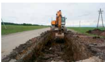
Рис. 3.1. Ремонт участка с избыточным увлажнением грунта, ликвидация пучин
