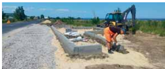
Рис. 3.3. Установка удерживающих ограждений и устройство остановки общественного транспорта
