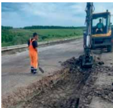
Рис. 3.2. Восстановление кромки проезжей части при ремонте автомобильной дороги
