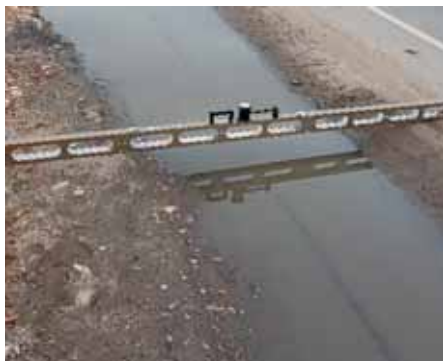
Рис. 2. Продавливание обочин под действием колесной нагрузки
