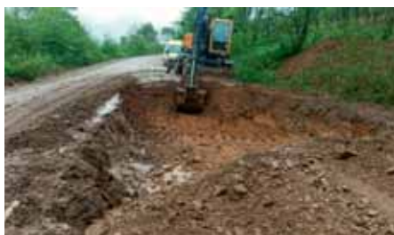
Рис. 3.1. Ремонт участка с избыточным увлажнением грунта, ликвидация пучин
