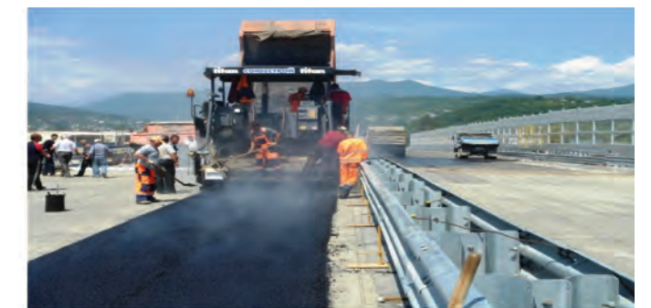
Асфальтовое покрытие на мостах
