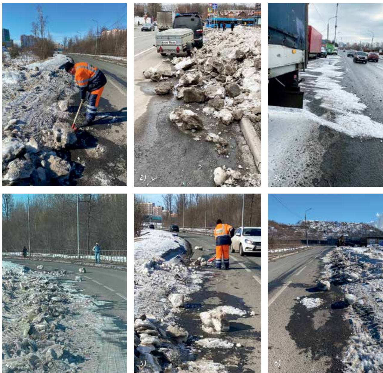
Рис. 2. Перемещение снега на проезжую часть дорожного покрытия: 1) дорожный рабочий перемещает снежные комья на проезжую часть; 2) комья снега, перемещенные на проезжую часть городской улицы; 3) перемещенный снег на проезжую часть; 4) снег на проезжей части после его перемещения; 5) дорожный рабочий дробит снежные комья и перемещает их на проезжую часть; 6) результат перемещения снега на полосу проезжей части.
