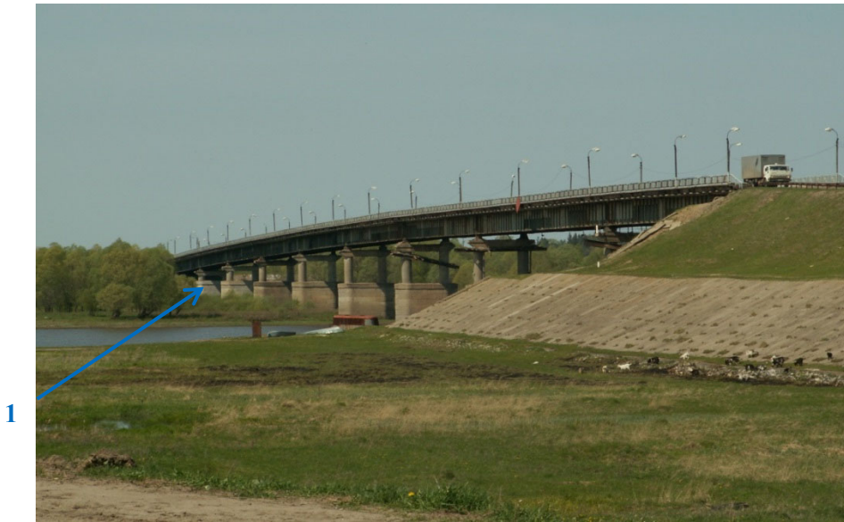
Рис. 1. Общий вид моста через р. Сура в г. Ядрин Чувашской Республики: 1 – опора № 2
