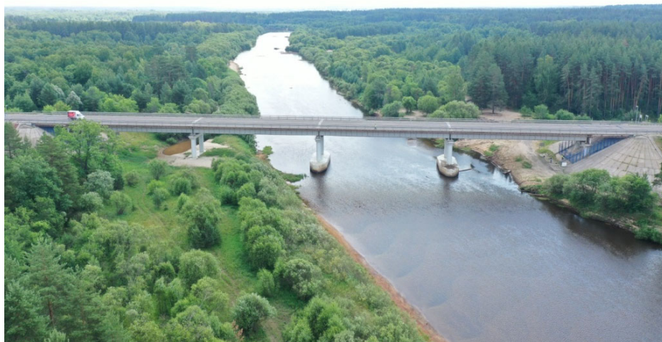
Рис. 4. Общий вид моста через р. Б. Кокшага на км 35+405 Автомобильной дороги Р-176 «Вятка»
