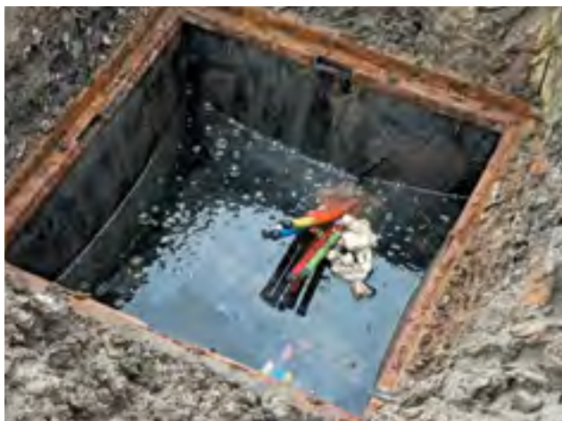
Рис. 9. Затопление СУ в обочине автомобильных дорог
