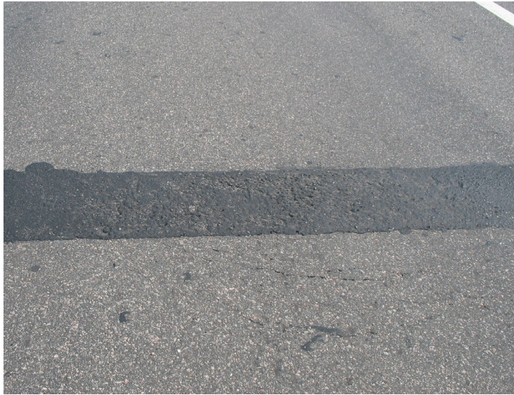
Рис. 2. Щебеночно-мастичный деформационный шов с армирующим материалом после эксплуатации в течение 7 месяцев
