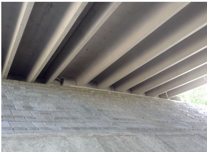
Рис. 7. Подмостовой осмотр после 5-летней годичной эксплуатации шва
