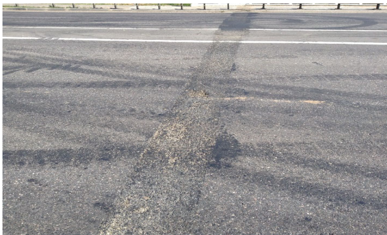
Рис. 6. Вид устроенного экспериментального щебеночно-мастичного деформационного шва после 5 лет эксплуатации
