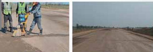
Предварительная нарезка швов на затвердевшем наноструктурированном шлакобетоне производится в течение 7-14 суток, на захватке до 3-5 км., для устранения их отражения на асфальтобетонном слое верхнего покрытия.
