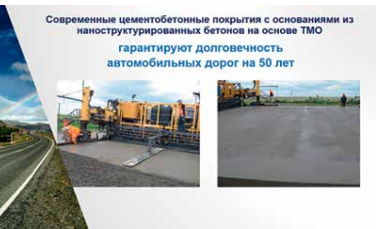
Рис. 4. Фото 2007 года. Строительство цементобетонного покрытия км 07–57 Астана – Щучинск с использованием в основании монолитного золобетона М350, F200, с промежуточным дренажирующим и виброгасящим слоем из щебеночно-песчаной смеси (М1000)
