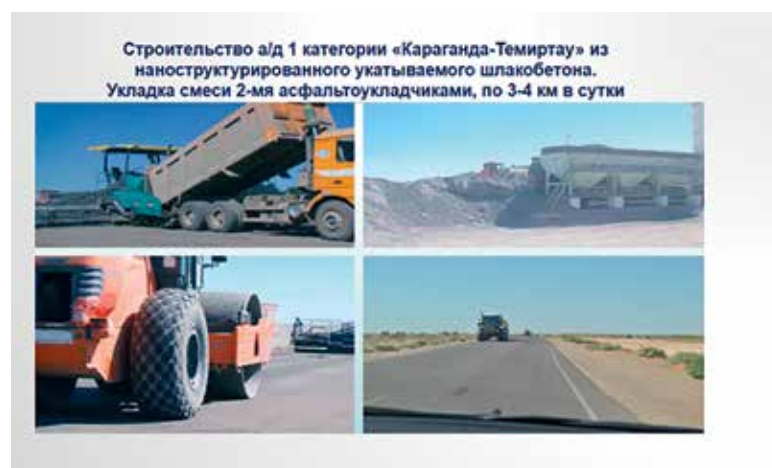
Рис. 5. Фото 2016 года. Строительство автомобильной дороги Караганда – Темиртау со слоем износа из асфальтобетона на укатанном шлакобетонном покрытии. Шлакобетонную смесь готовили в бетоносмесительной установке
