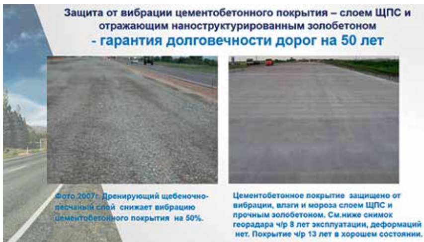
Рис. 3. Фото 2007 года. Слой из дренажирующего ЩПС снижает вибрацию цементобетонного покрытия, а водонепроницаемое золобетонное основание исключает переувлажнение верхних слоев дорожной одежды от поднятия капиллярной влаги от УГВ
