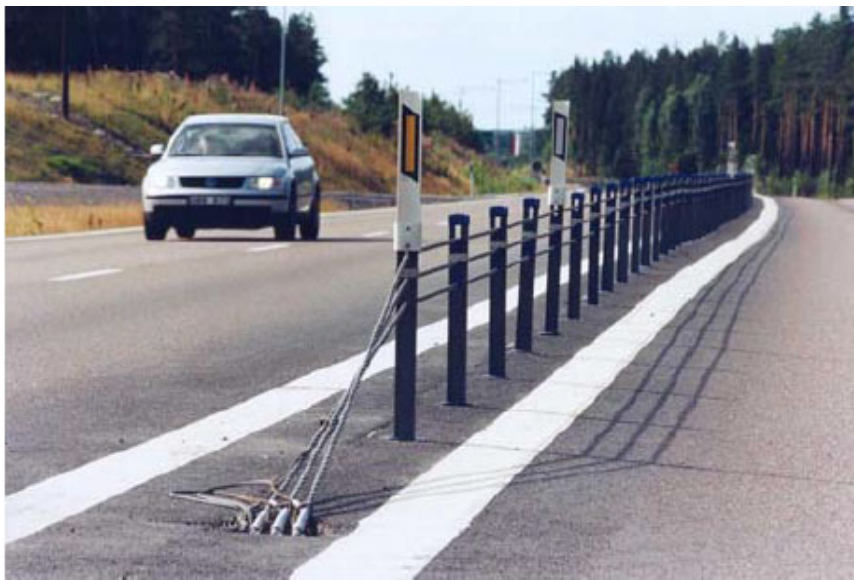
Рис. 4. Тросовые ограждения на разделительной полосе на автомобильных дорогах «2+1» в Швеции
