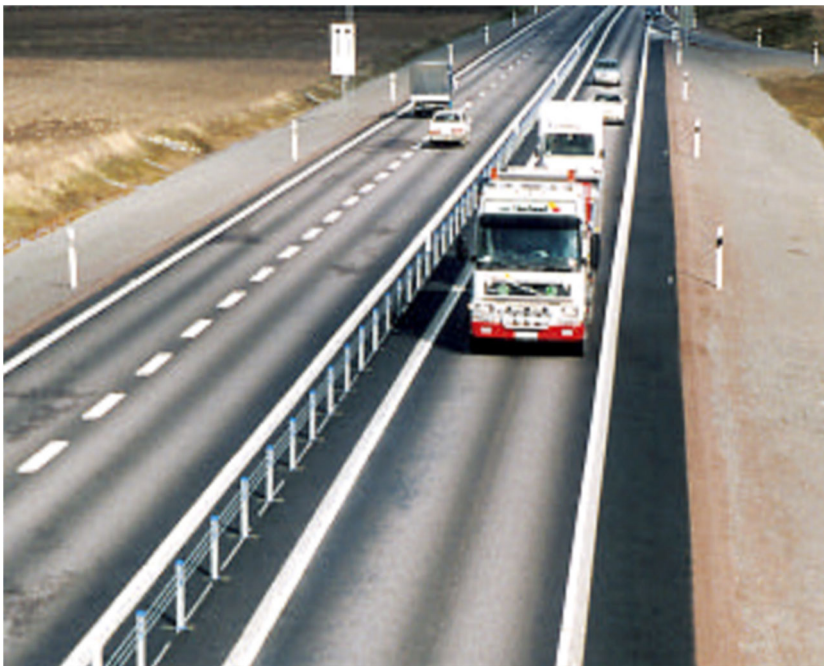
Рис. 5. Автомобильные дороги «2+1» в Ирландии (NRA, 2004)
