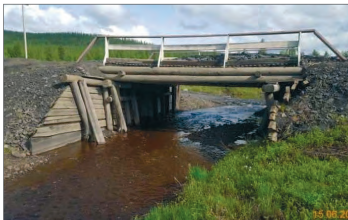
Рис. 3. Малый деревянный мост, ввод в эксплуатацию — 1952 год
