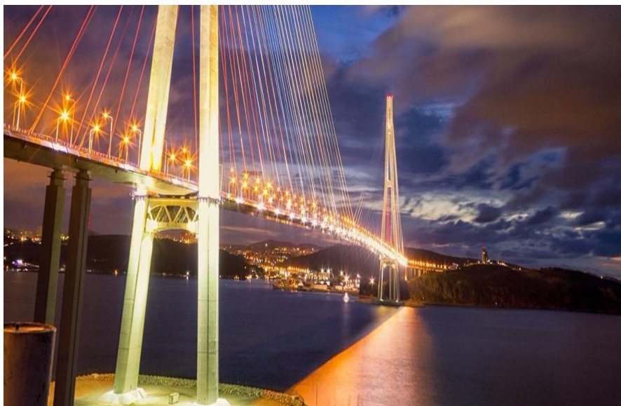
Рис. 1. Мост на остров Русский через пролив Босфор Восточный во Владивостоке
