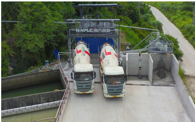
Рис. 8. Комплекс системы рециклинга остаточного бетона серии WCRE60 компании NFLG (Китай)
