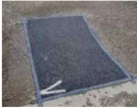
Рис. 4. Применение битумной ленты или битумного герметика в местах стыка ремонта выбоины
