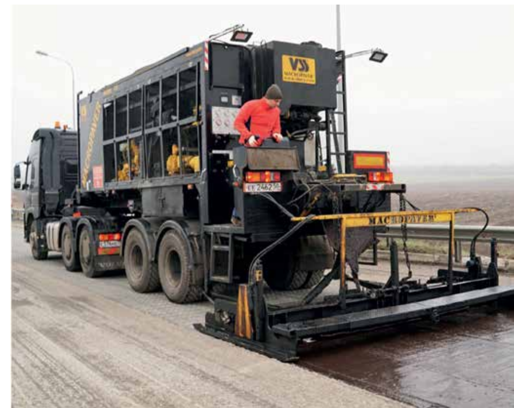
Закрепление сетки с помощью слоя ЛЭМС
