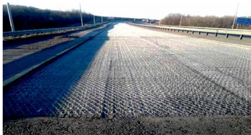
Стальная сетка, уложенная в основание дорожного покрытия
