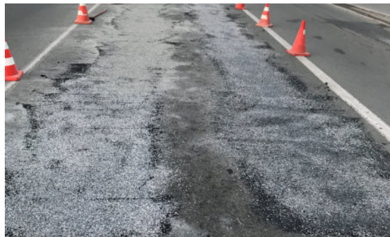
Рис. 17. Нанесение на УЗД отсева щебня
