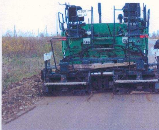
Укладка гидро-полимер-цементно-грунтовой смеси из композитных материалов
