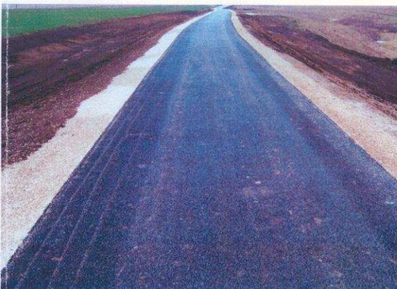
Участок дороги п.Шатки-д.Гаврилово с полимер-щебеночно-мастичным асфальтобетонным слоем износа из малопрочных каменных материалов М 600...М 800
